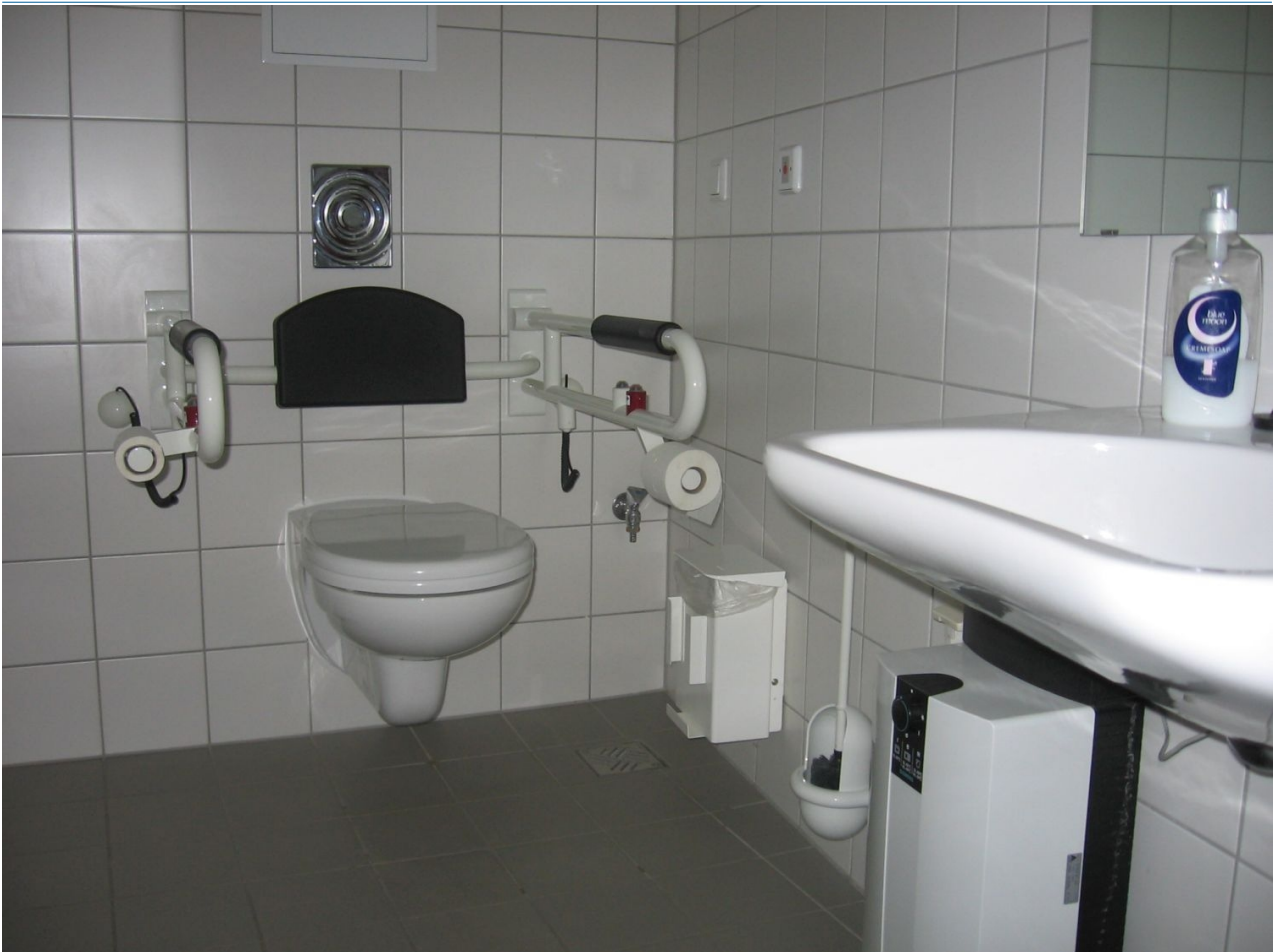
Weitgehend barrierefreie Toilette
